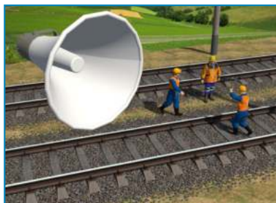
Оповещение эксплуатационного персонала о вступлении поезда в зону работы
